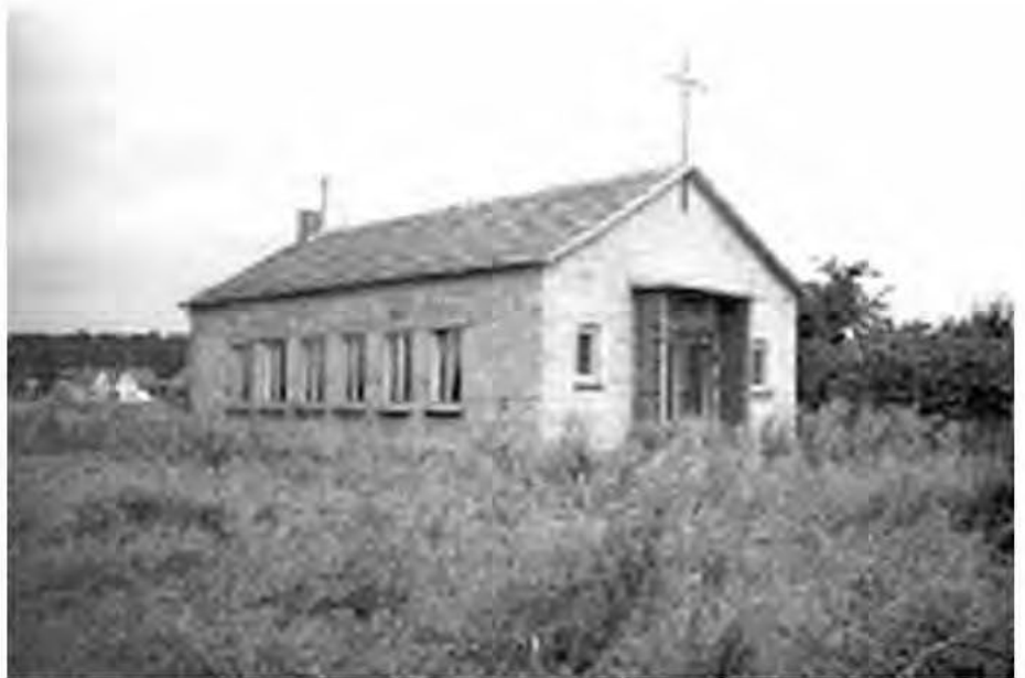
Die Gemeinde baute 1953 ein neues Gemeindehaus in Leimfeld. Es steht auch heute noch
