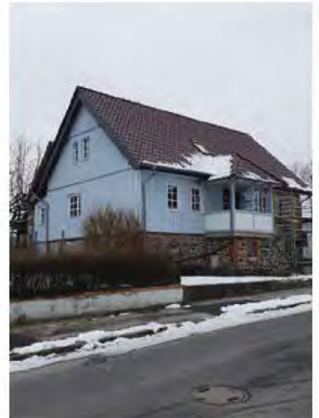
Gemeindehaus Leimfeld Bahnhofstr.
